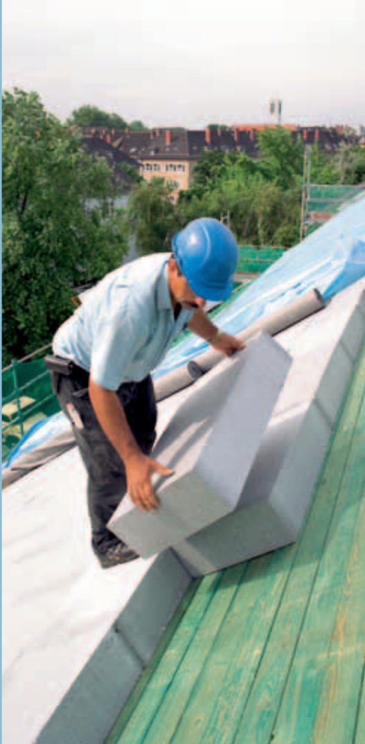
Energetische Sanierung im Bestand schafft Arbeit
